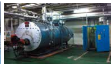
▲ 鍋爐汰換工程
