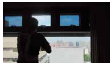
▲ 玻璃隔熱紙安裝工程
